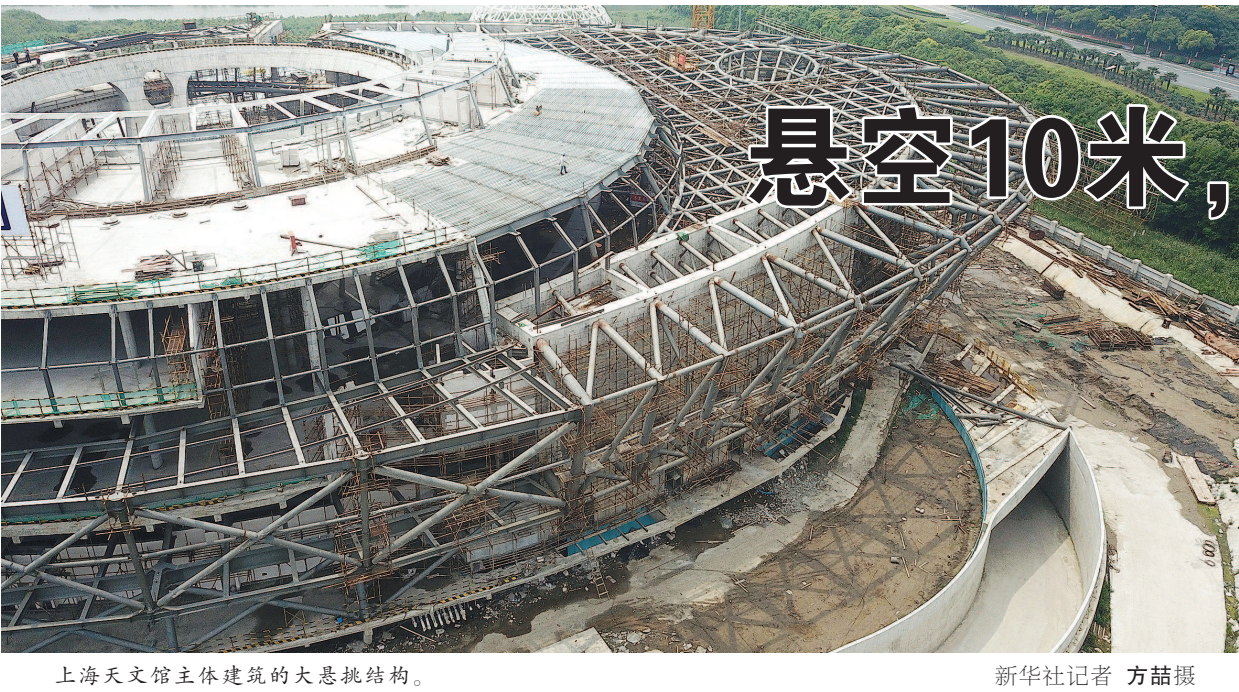
上海天文馆主体建筑的大悬挑结构。
