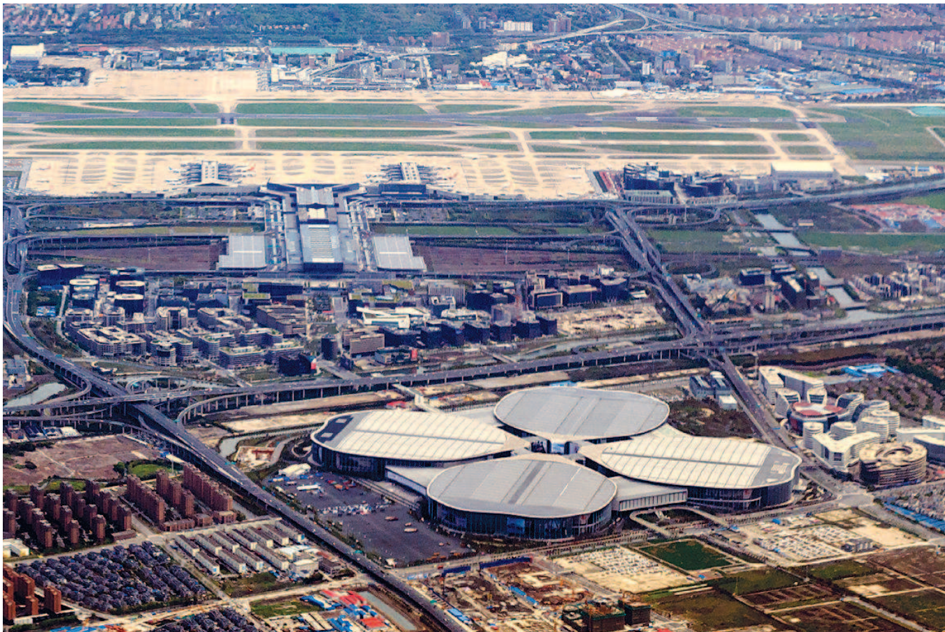
图为航拍的虹桥交通枢纽、国家会展中心。
