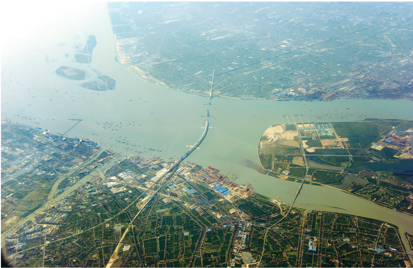
飞机从上海浦东机场起飞至上海江苏交界上空,透过舷窗俯瞰,沪通长江大桥正在紧锣密鼓地建设施工。
