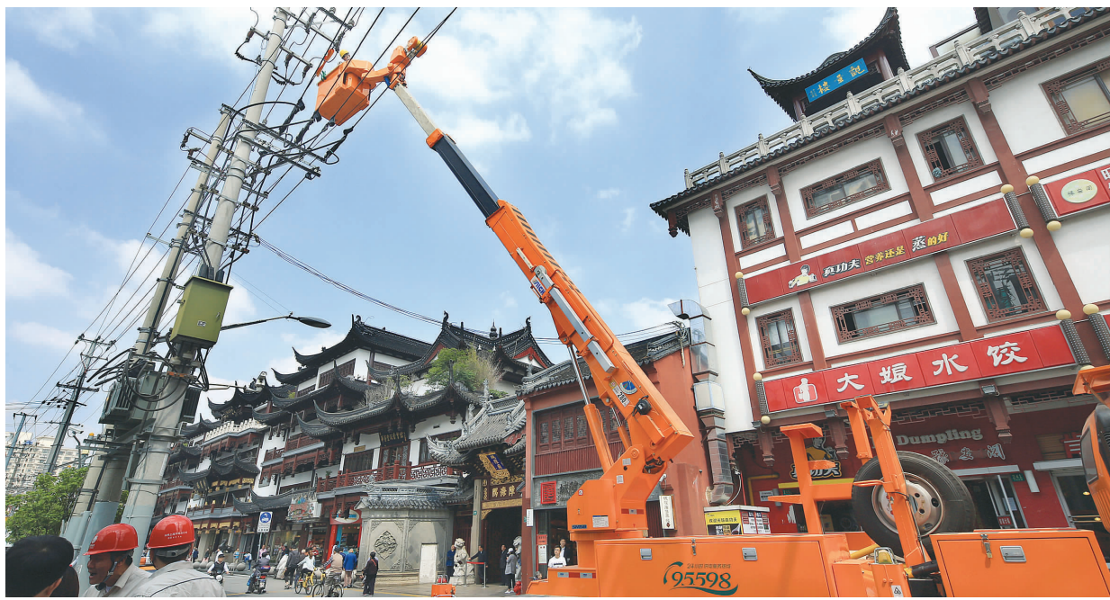
国网上海市区供电公司带电作业班组在城隍庙附近以带电作业方式进行杆上消缺检查。国网上海市电力公司供图
