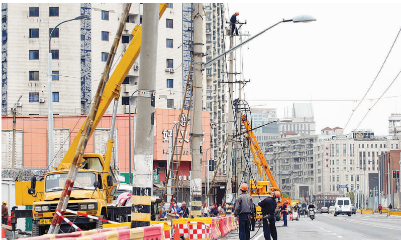
几名工人正在拆除电力线缆设施。本报记者 叶辰亮摄
