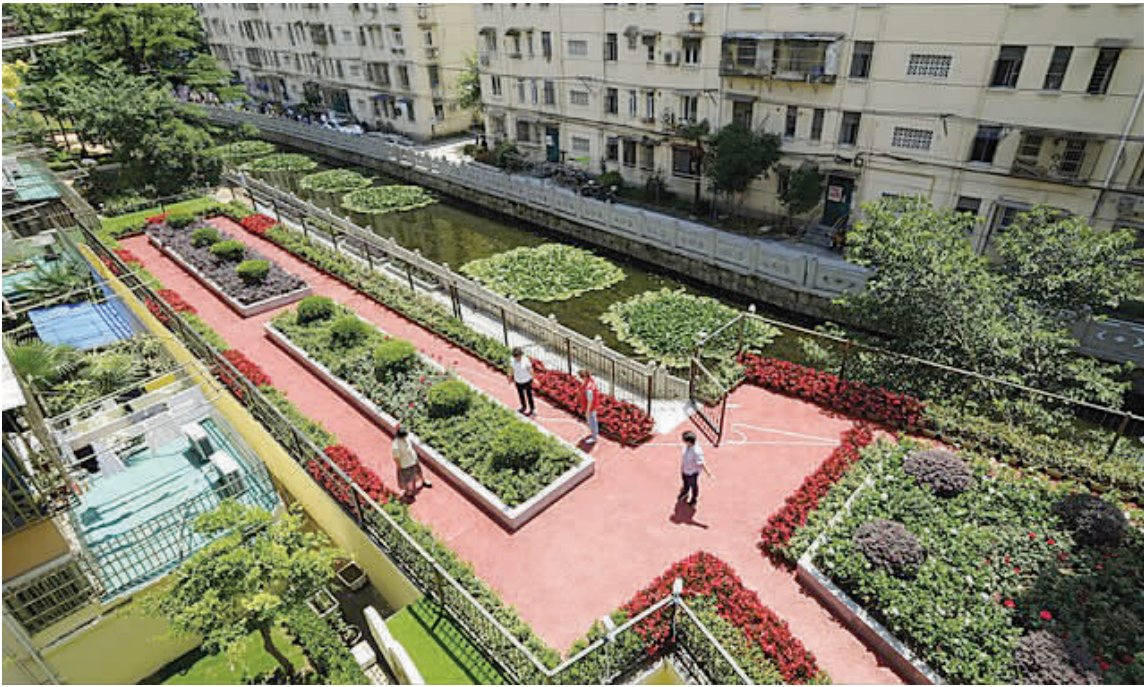
经过改造,杏杨园的小区车棚保留部分原有的黑色沥青屋顶,改造成盆景式屋顶花园。花园里的植物主要为低矮的灌木,这样既减少了车棚承重压力,也不遮挡居民采光。 (普陀区供图)
