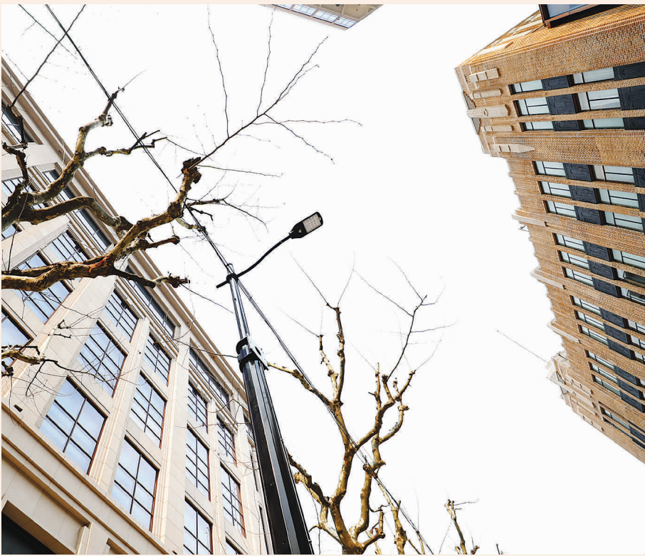
河南中路、江西中路之间的南京东路上,已竖起黑色智能合杆。均本报记者 袁婧摄
