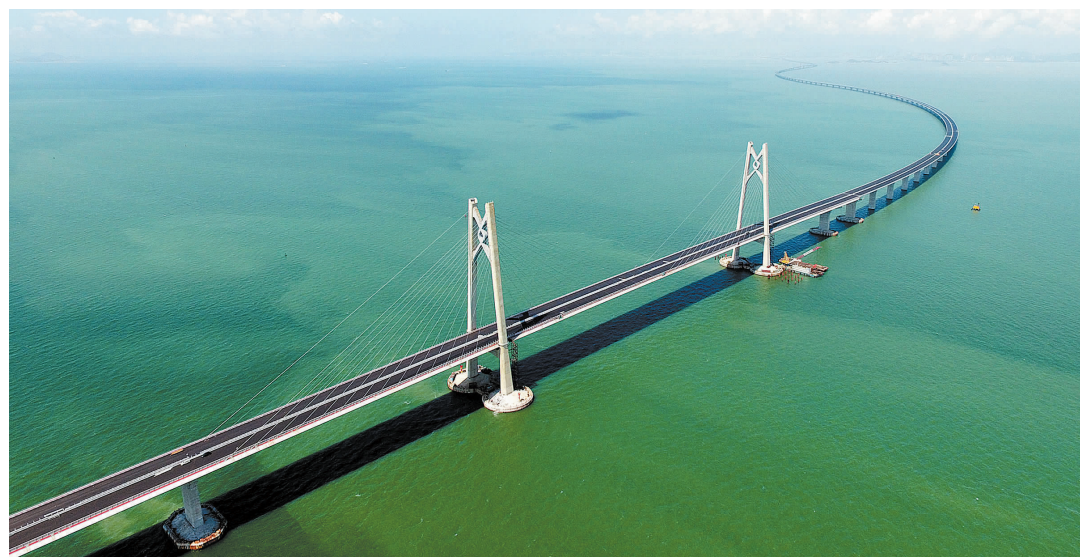
港珠澳大桥桥、岛、隧为一体,建设规模庞大,施工环境复杂。其成功建设是桥梁工程的奇迹,更是科技创新的壮举。新华社记者梁旭摄
