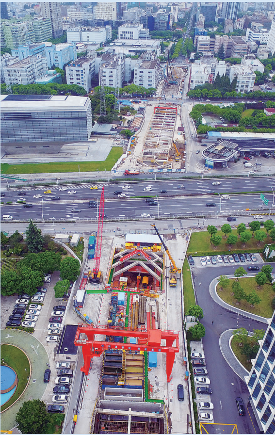
图为地道工程管幕顶进施工现场鸟瞰图
