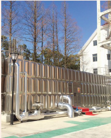
▲ 新启用的横沙岛新民泵站的智能化集成供水系统。本报记者 李静摄 ► 远眺青草沙水库。视觉中国
