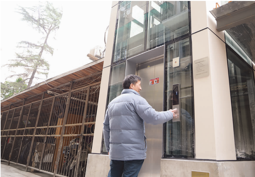
新民村装了新电梯，大大便利了居民出行。
