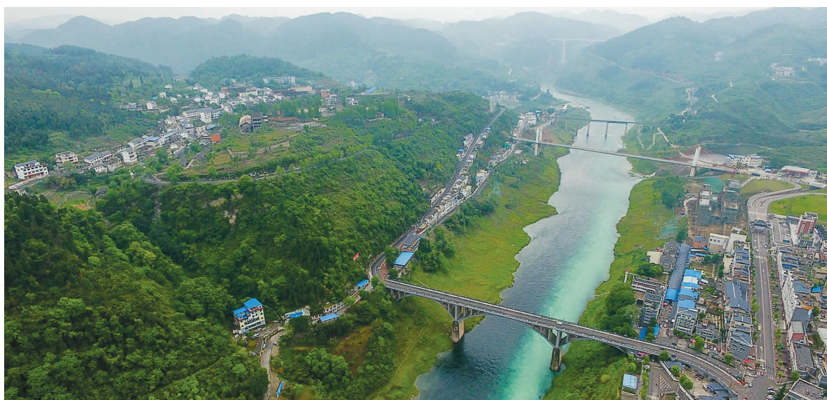
2017年5月8日航拍的贵州省乌江特大桥。贵州省借力大数据实现跨越式发展，依靠大生态守住长江上游屏障。新华社记者 欧东衢摄
