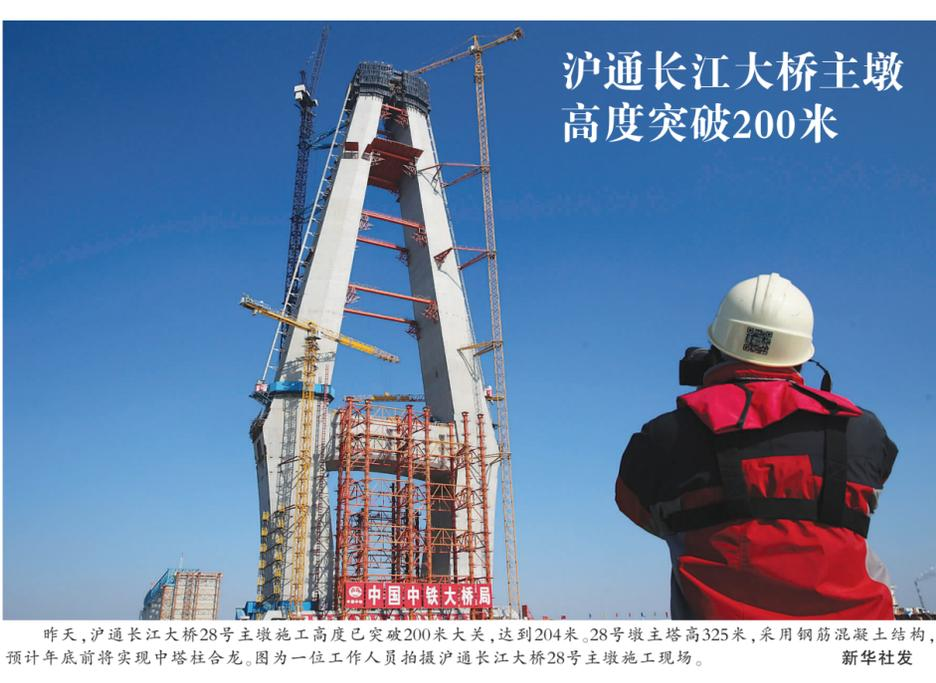
昨天,沪通长江大桥28号主墩施工高度已突破200米大关,达到204米。28号墩主塔高325米,采用钢筋混凝土结构,预计年底前将实现中塔柱合龙。图为一位工作人员拍摄沪通长江大桥28号主墩施工现场。 新华社发
