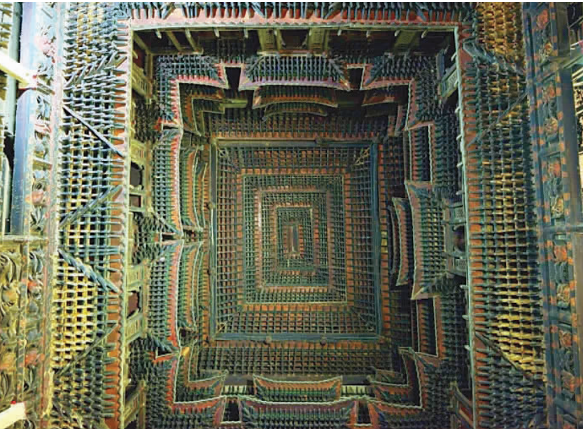
公输堂现存三间后殿,室内木构遍布彩绘。
