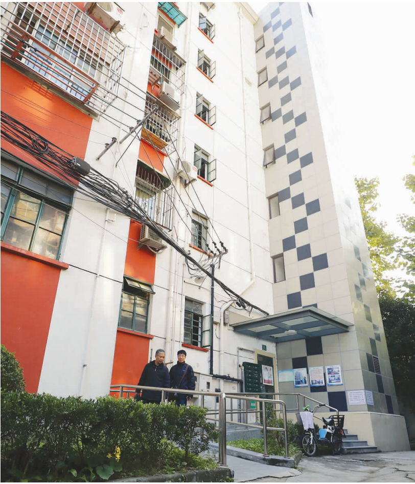
加装的电梯“穿”上靓丽的外衣,与小区建筑融为一体。
