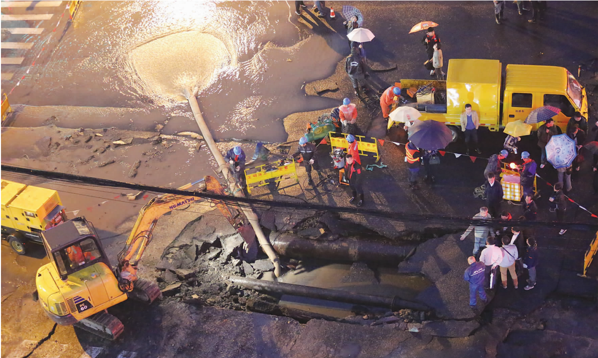
昨天下午,四平路溧阳路水管发生爆裂。图为施工人员进行连夜进行抢修作业。
