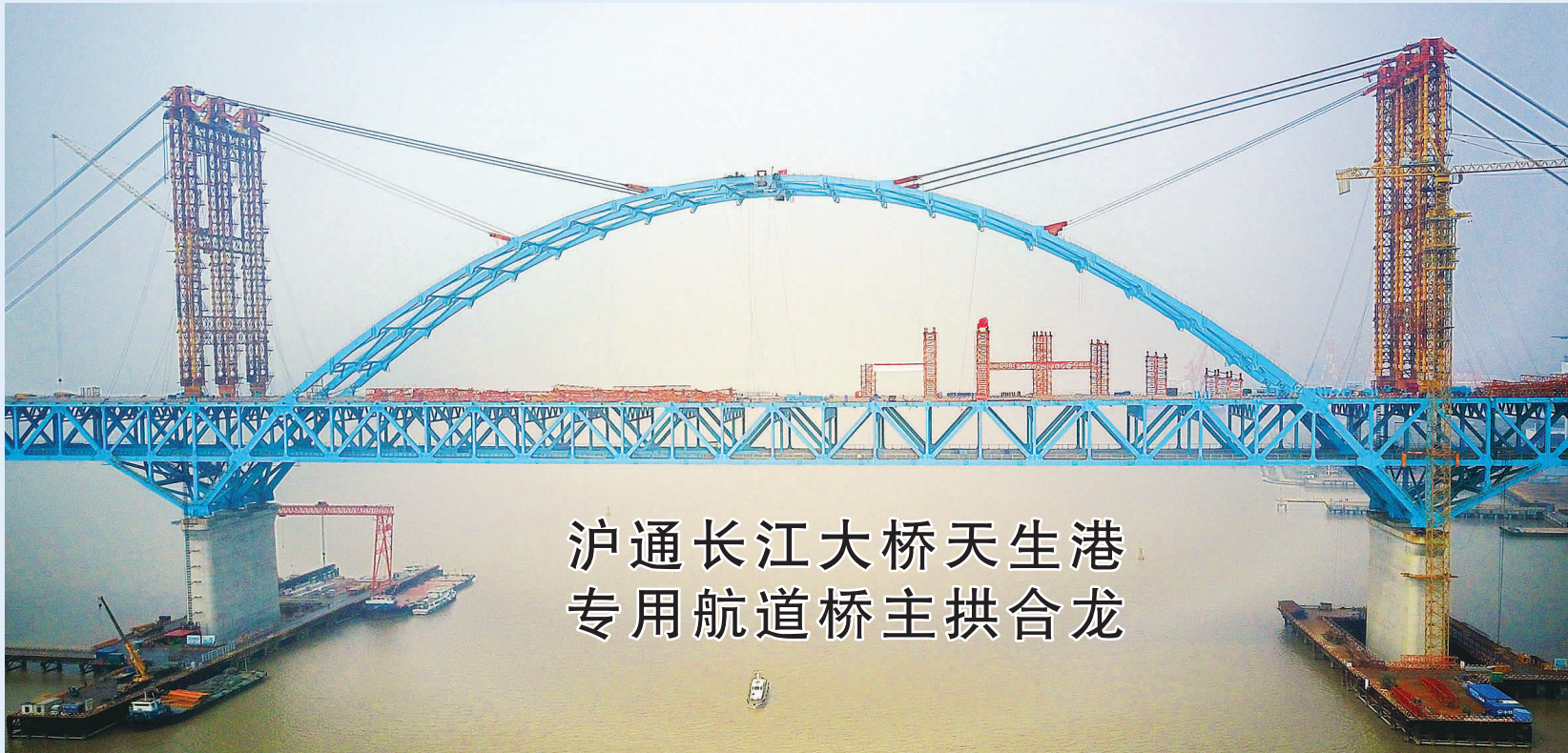
10月22日,由中交二航局承建的世界最大跨径公铁两用钢拱桥——沪通长江大桥天生港专用航道桥主拱合龙,标志着天生港专用航道桥全部成功合龙。沪通大桥是我国沿海铁路大通道沪通铁路控制性工程,连接张家港市和南通市。
