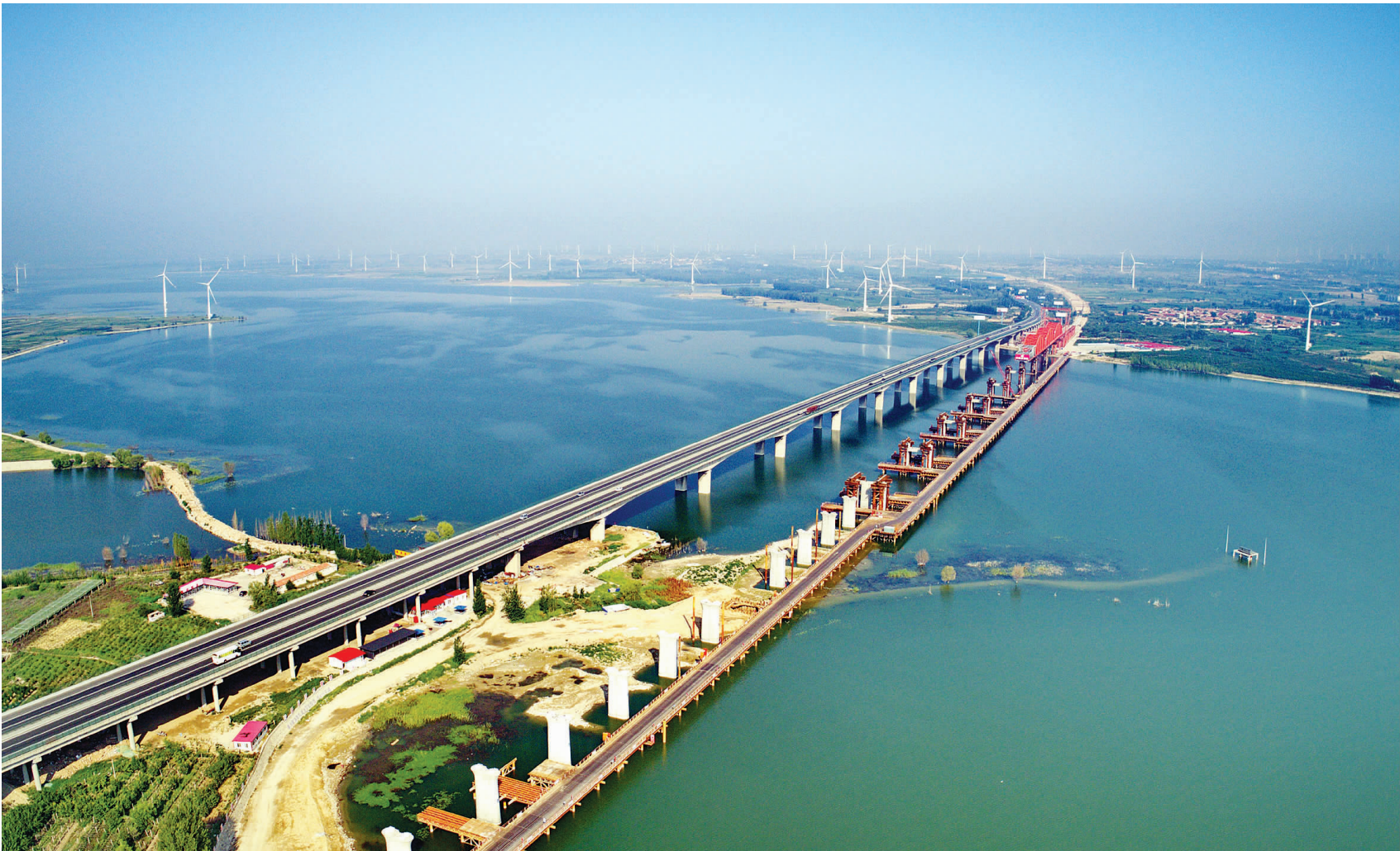
建设中的京张高铁是服务2022年冬奥会的交通要道，设计时速350公里，东起北京北站，西到河北省张家口市，正线全长174公里，预计2019年12月底建成通车。图为京张高铁工程官厅水库特大桥。
