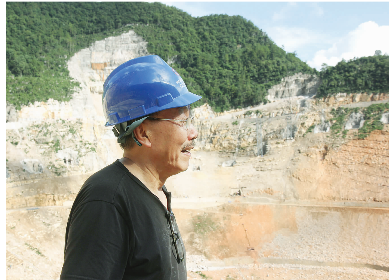
南仁东在大窝凼施工现场(2013年7月19日报)。
