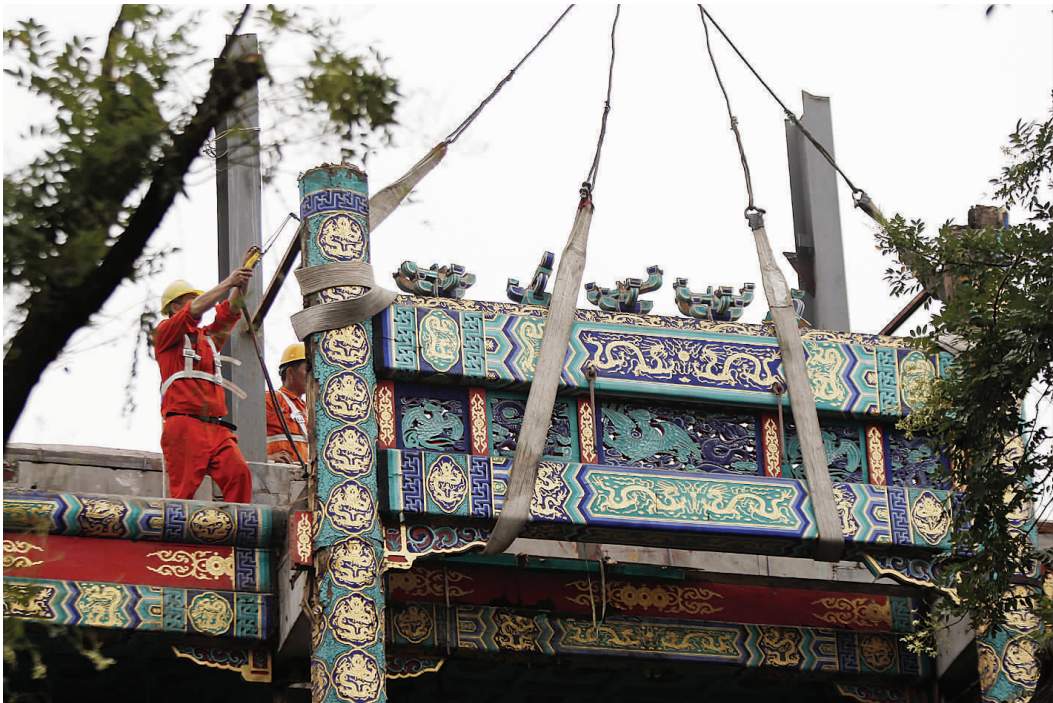
工人们在鼓楼西大街拆除沿街违法建筑。 图/视觉中国
