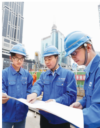
杜毅(中)与同事正在地铁建设现场结合图纸规划施工的安全性。袁婧摄
