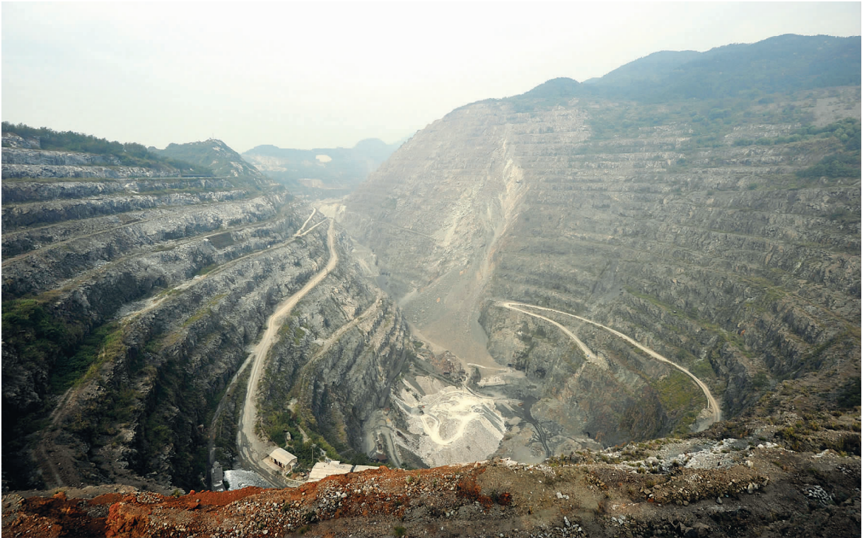
历经百年开采,大冶铁矿东露天采场形成了落差444米的世界第一高陡边坡。
