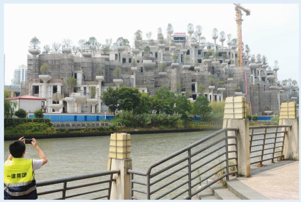
由上海建工一建集团承建的天安阳光广场西地块工程,位于普陀区苏州河南岸区域,南靠英干山路,西侧毗邻昌化路,140根顶上升满绿色植被的“艺术景观清水混凝土生命立柱”和55个露台,由南向北层层退台而下,一直延伸至苏州河沿岸绿化带,远看就像一座“空中花园”。
