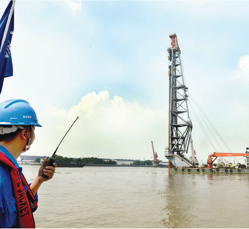
昆陽路越江大橋昨已開始主墩施工。
