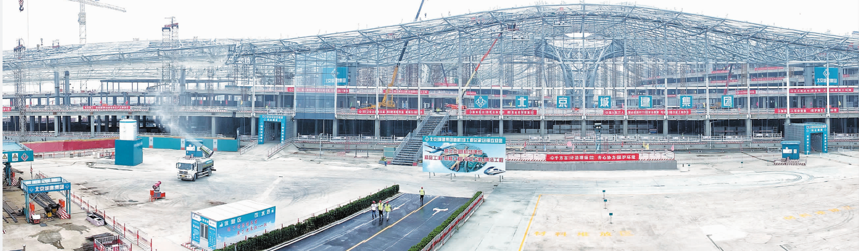
位于北京市大兴区和河北省廊坊市交界处的北京新机场建设顺利,目前新机场航站楼钢结构已经封顶,航站楼玻璃幕墙、二次结构及机电设备安装工作陆续展开。据北京新机场建设指挥部介绍,新机场将于2019年建成投入使用。图为建设中的北京新机场航站楼。 新华社记者 李欣摄
