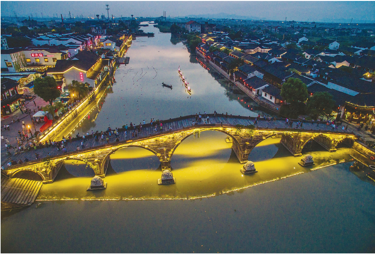
位于京杭大运河上的浙江塘栖古镇广济桥两侧的夜景(2015年9月24日摄)。 新华社记者 徐昱摄
