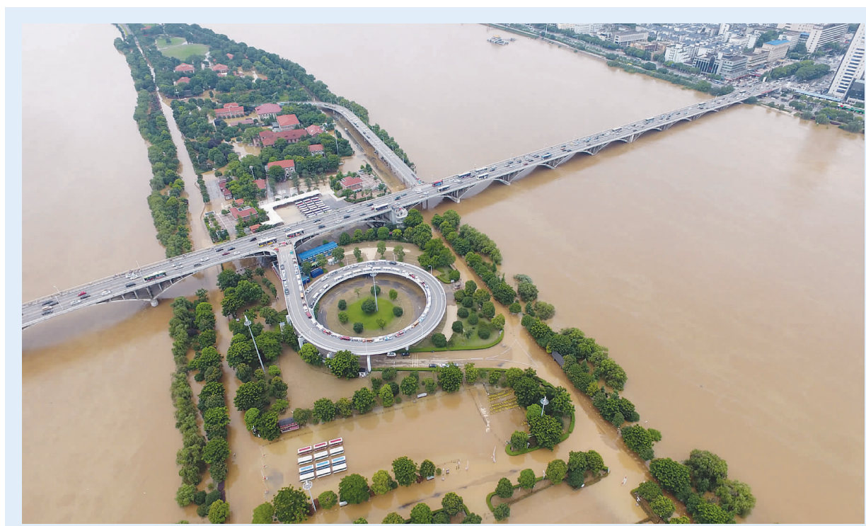
4日航拍的洪水包围下的长沙橘子洲大桥,桥下的橘子洲景区因被水淹没已经对外封闭。新华社记者 龙弘涛摄
