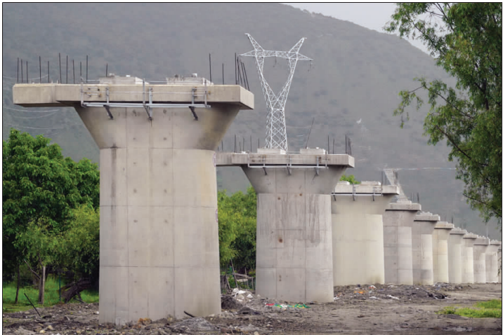
▲川藏铁路拉林段在建桥墩施工现场。
