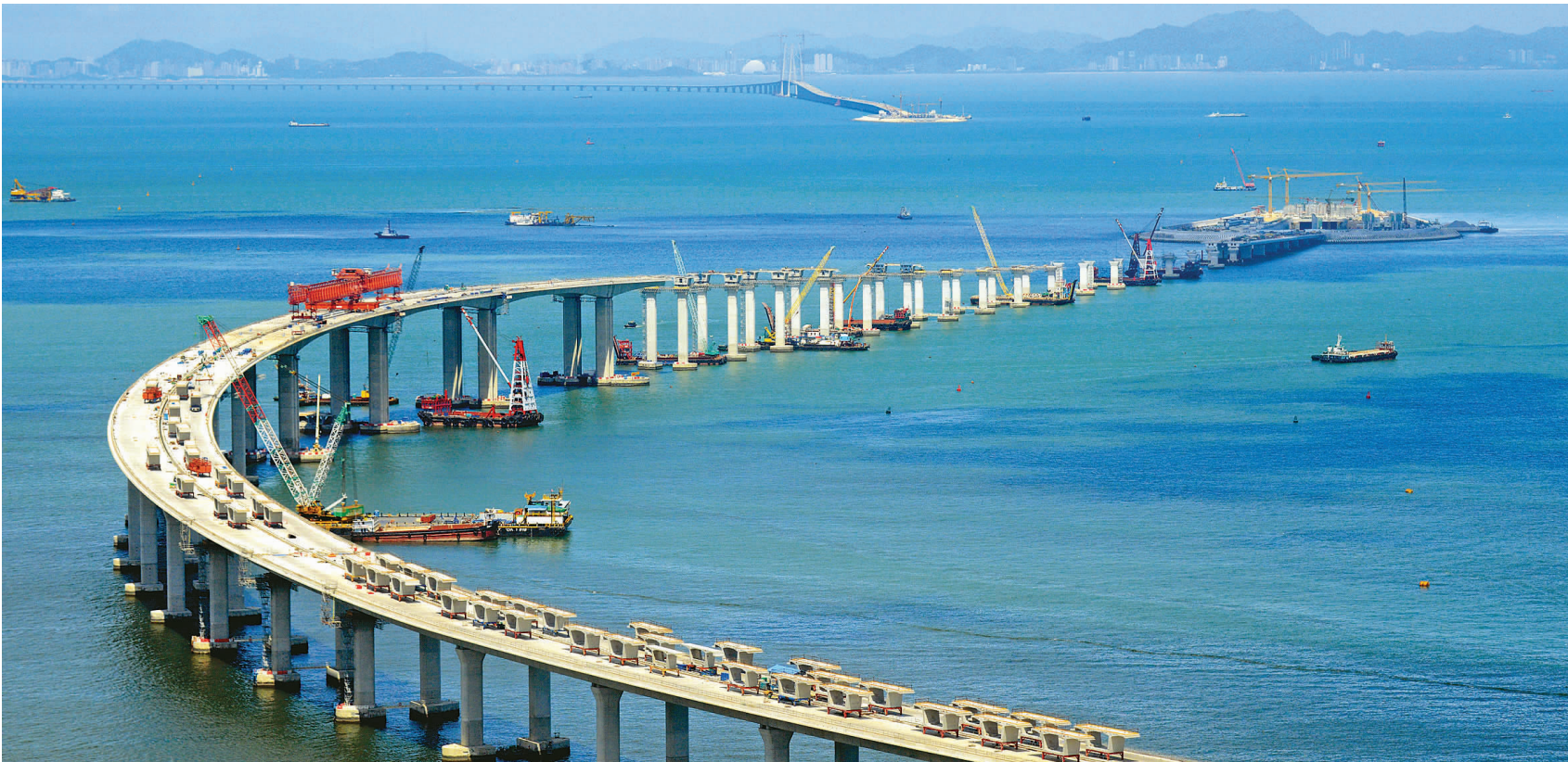
今年5月,港珠澳大桥海底隧道和香港接线相继贯通,全长55公里的世界最长跨海大桥将在年内实现全线贯通。图为港珠澳大桥工地。
