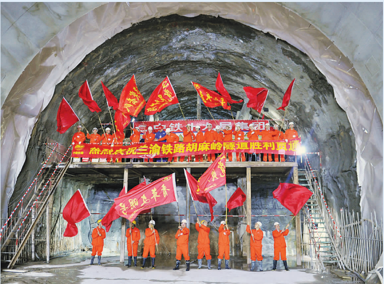
在兰渝铁路胡麻岭隧道内,工程技术人员欢呼庆祝隧道成功贯通。新华社记者 郭刚摄
