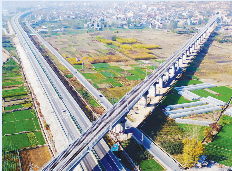
兰渝铁路陇南境内的汉王白龙江特大桥(上)与高速公路交错。新华社记者 陈斌摄
