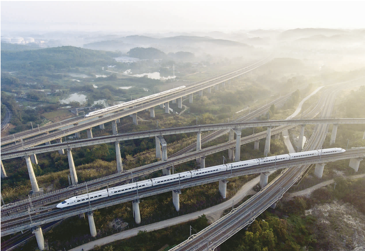
动车行驶在广西南宁市屯里特大桥上。
