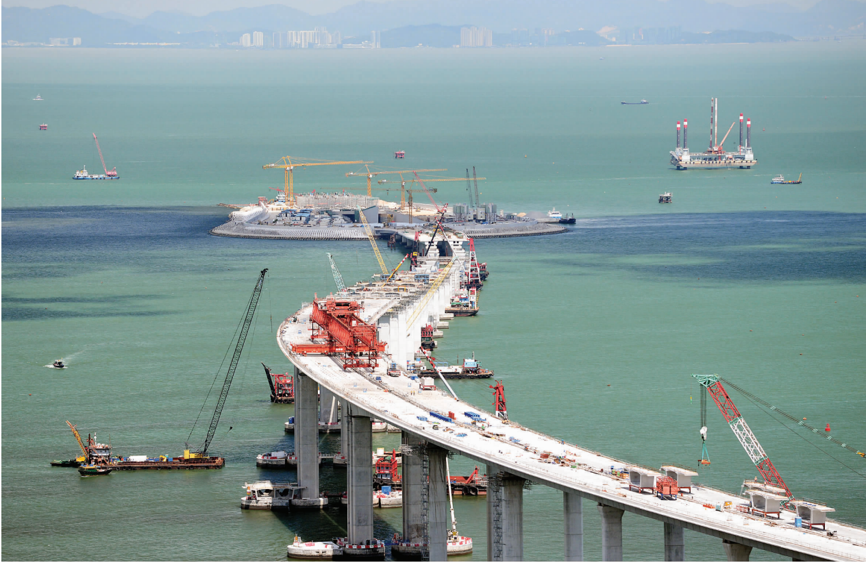
港珠澳大桥建成通车后,珠海、澳门至香港的交通时间将由现在的水路约 1 小时、陆路 3 小时以上,缩短至 20 到 30 分钟之内。图为港珠澳大桥工地。
