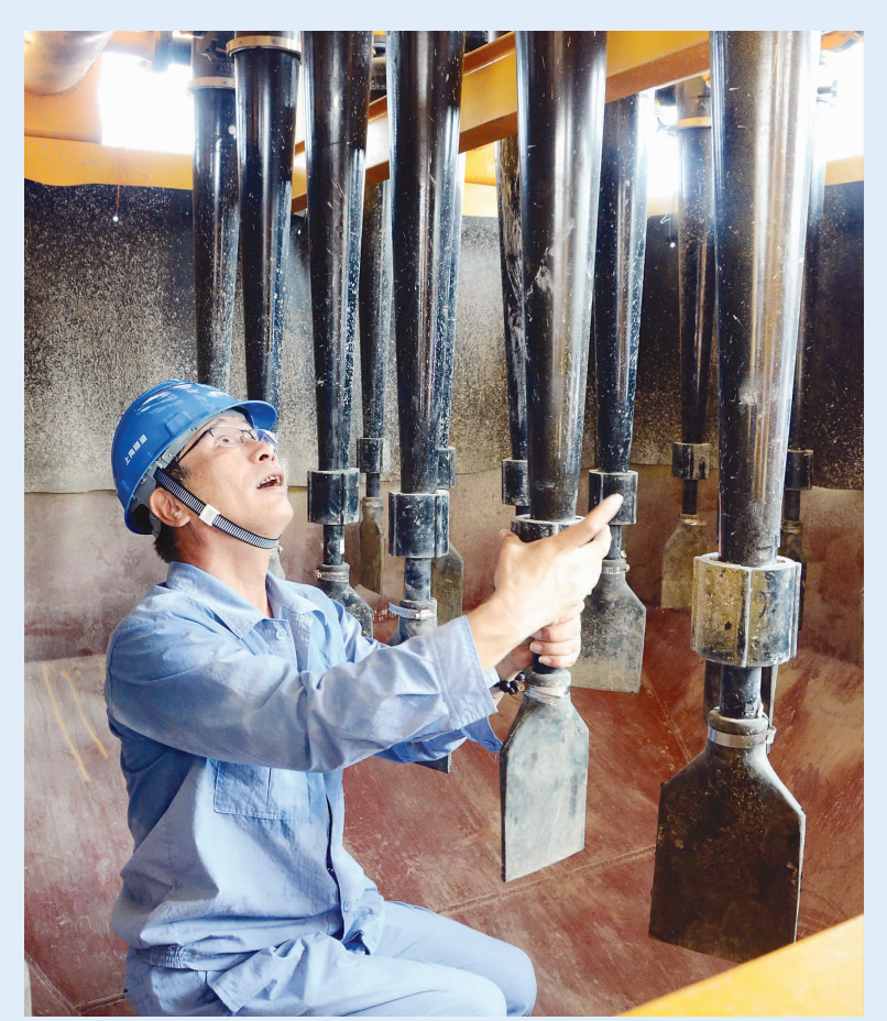
李鸿在测试泥水分离设备中的漩流器。(隧道股份上海隧道供图)
