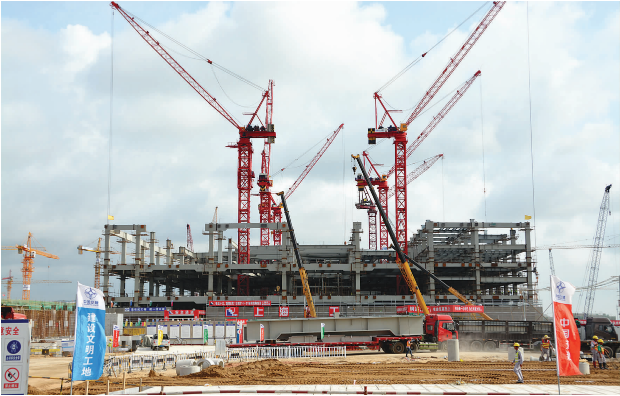
由上海建工集团承建的港珠澳大桥澳门口岸旅检大楼项目，预计月底钢结构全面封顶。（上海建工集团供图）
