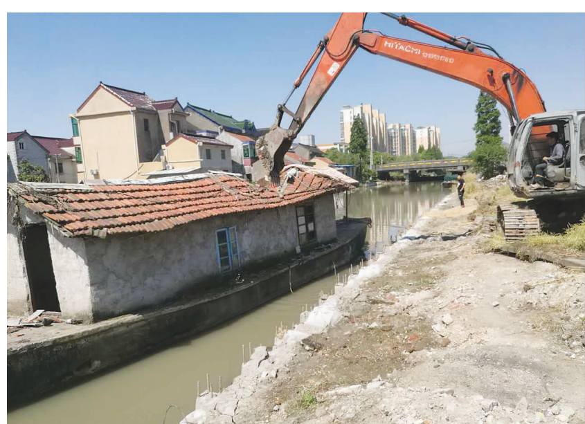
工作人员正在拆解“三无”居家船舶。(金山区新闻办供图)
