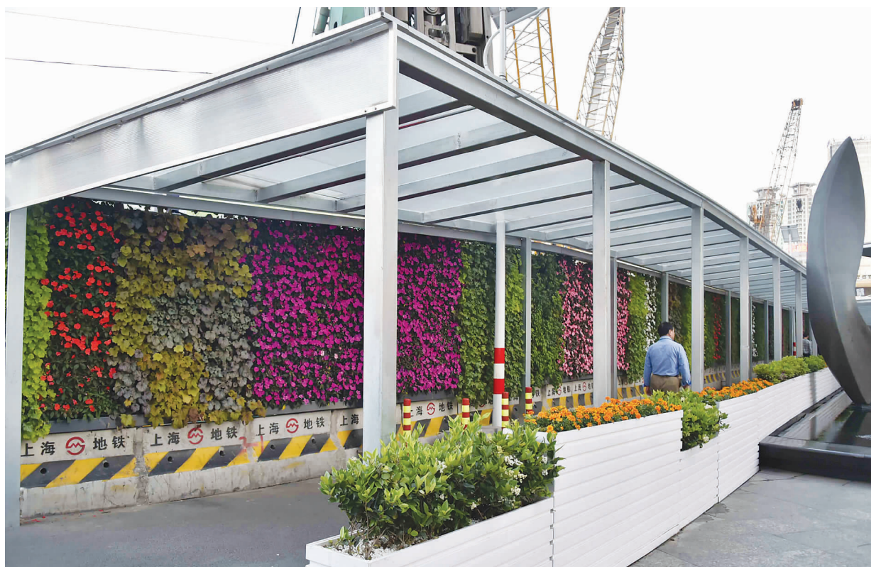
工地四周都种上了花草，紧邻华山路间距不到3米的通道上做了一个顶棚防止泥浆溅出。本报记者 赵立荣摄
