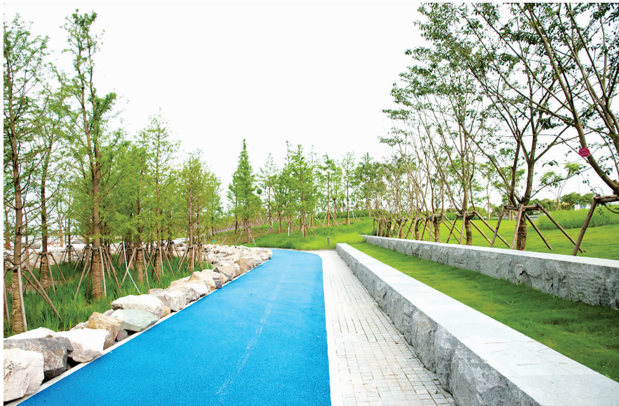
海绵城市首期样板工程目前已全部完工，图为环湖景观带蓝色透水铺装。
