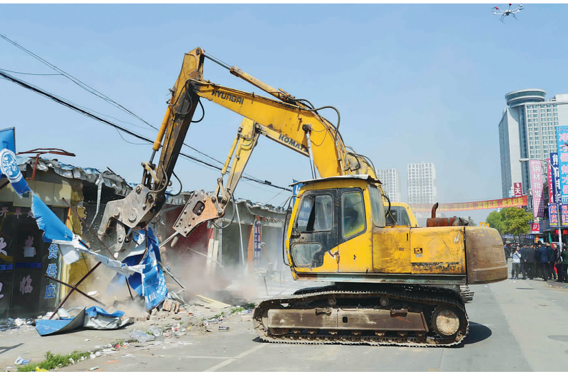
嘉定区消防支队联合属地城管对位于宝安公路上的“三合一”违法建筑全面拆除。 本报记者 赵立荣摄
