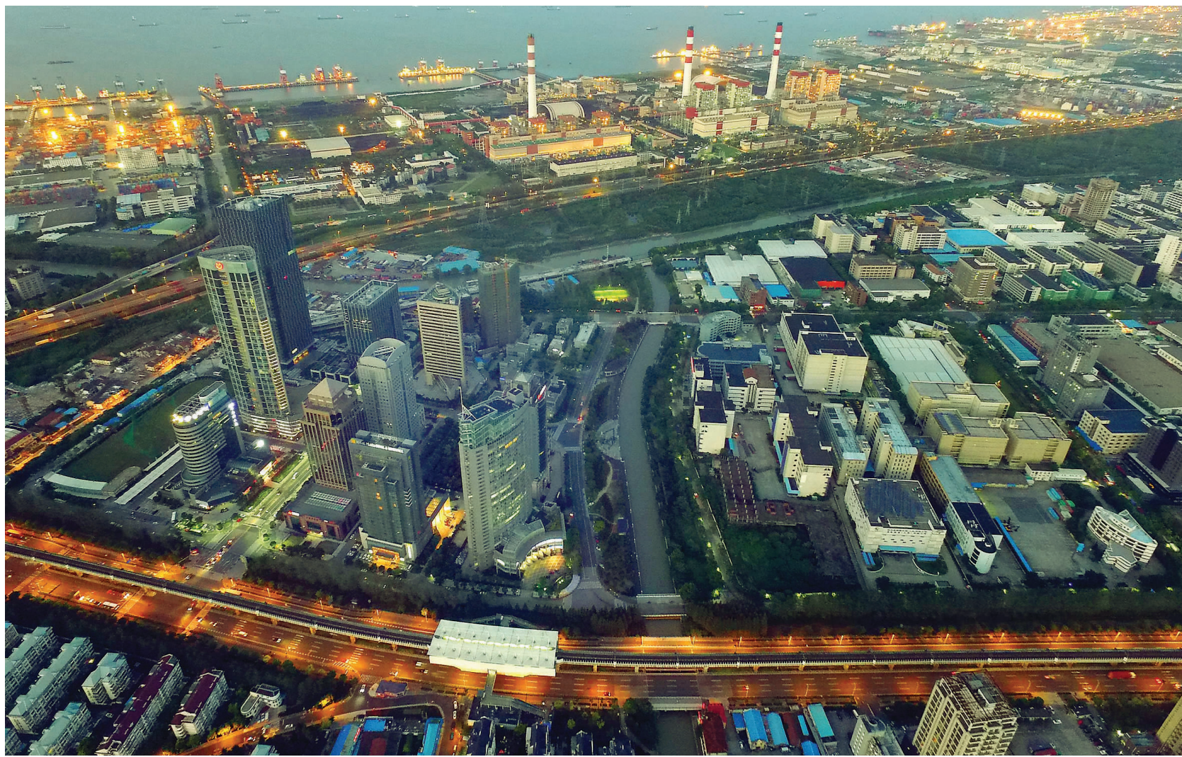
俯瞰上海自贸区外高桥保税区及物流园区。
