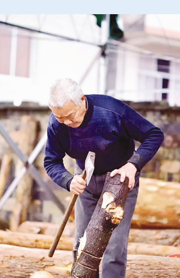
省级木拱桥传统营造技艺传承人郑昌贵主持薛宅桥修复。钟晓波摄
