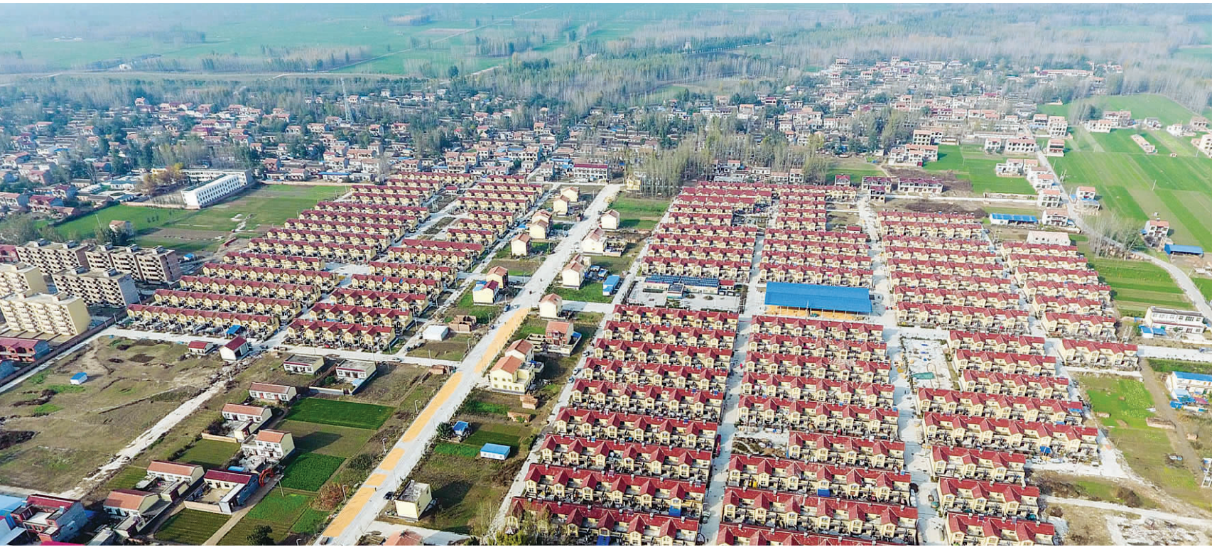
用于河南省兰考县黄河滩区搬迁的兰考县谷营镇姚寨新村社区。
