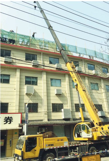
昨天上午,虹口提篮桥地区 2000 平方米的违法建筑被拆除。(虹口区供图)
