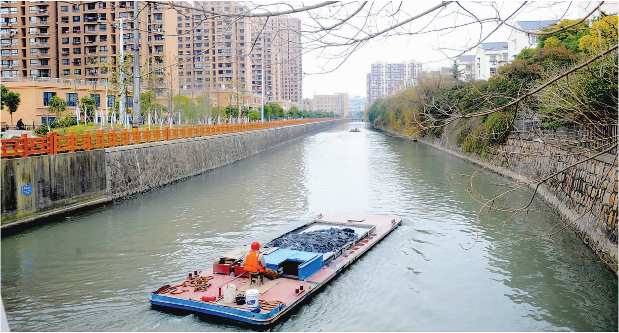
俞泾浦河疏浚已完成84%,计划4月底前全部完成。
