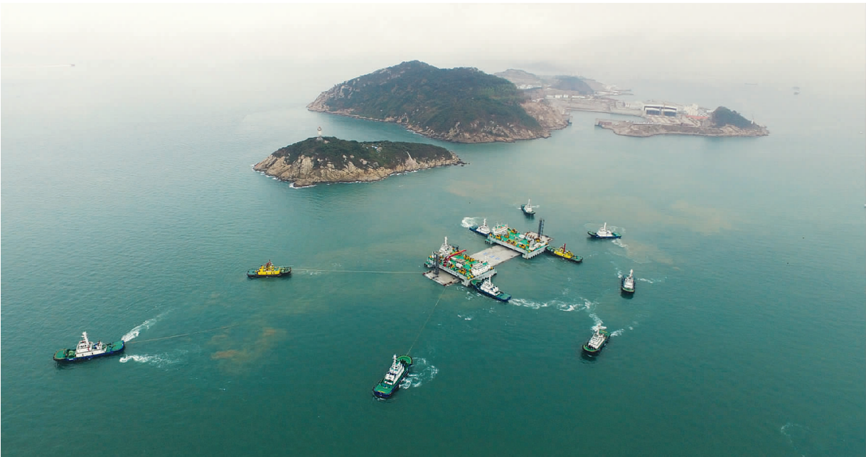
浩浩荡荡的船队将沉管拖往施工海域。
