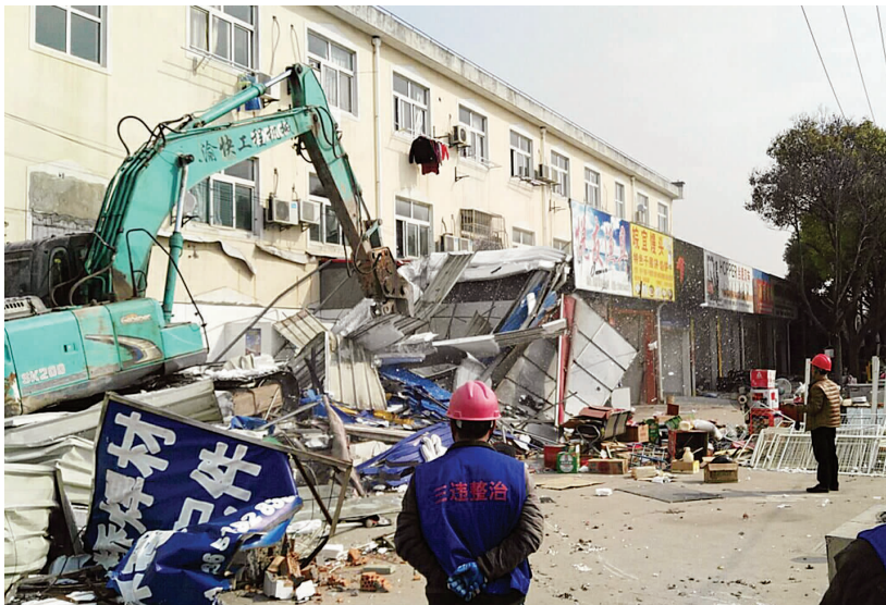
昨天，工作人员正在拆除康桥东路和金桥路路口的违建门面房。（浦东新区城管执法局康桥镇中队供图）
