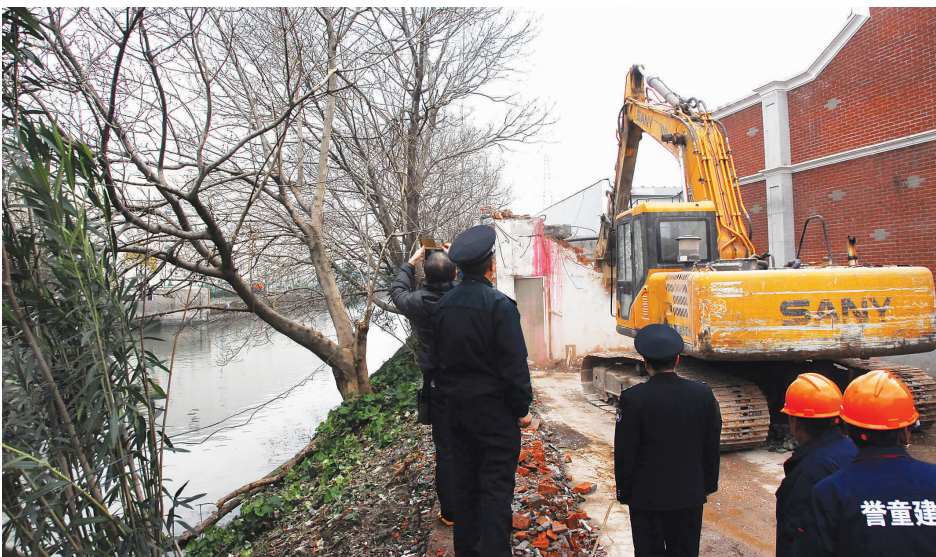
执法人员在彭浦新村街道东菱泾河旁拆除违章建筑。
