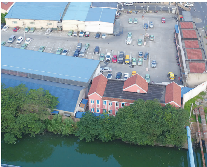
东菱泾河原先岸边违建建成片。（静安区拆违办供图）
