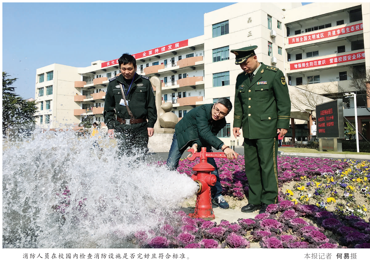
消防人员在校内检查消防设施是否完好且符合标准。
