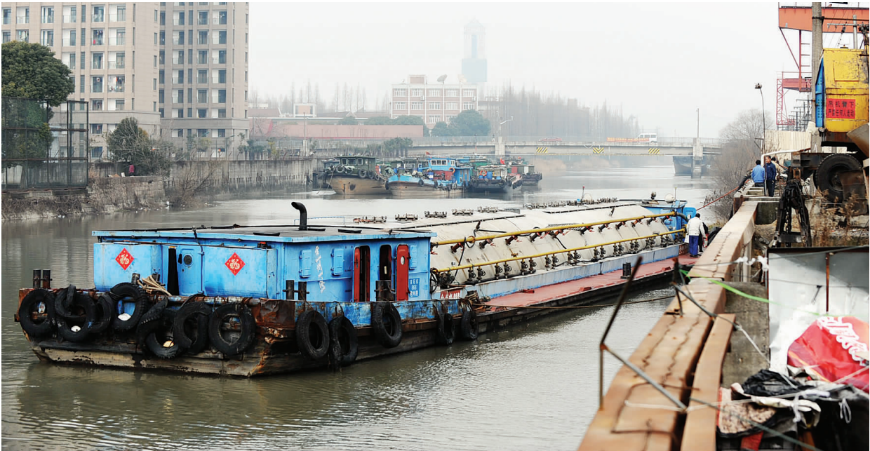
复兴岛运河上的大型船只在河道内掉头,螺旋桨搅动防汛墙下的淤泥,导致不少防汛墙下沉,造成极大安全隐患。袁婧摄
