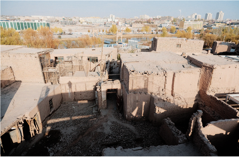
有的高台民居被拆了，有的被整修，通上了水电。
