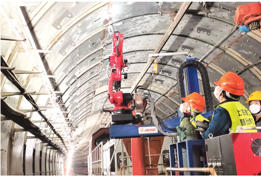
上海建工下属基础集团自主研发的自动焊接机器人,用激光自动寻位系统,全断面焊接隧道内钢环加固横缝,达到治理隧道收敛变形的效果。(受访者供图)
